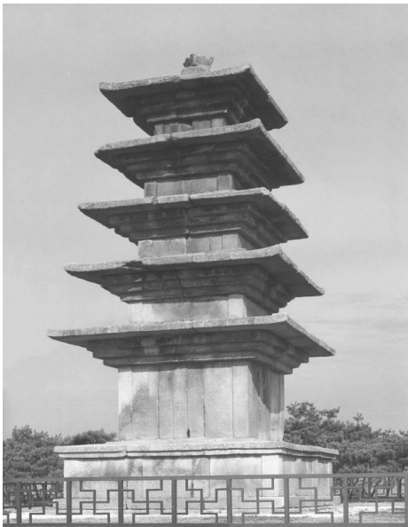
(사진 21) 왕궁리 오층석탑 나말여초 국보 289호 8.5m 전북 익산시 왕궁면 왕궁리
